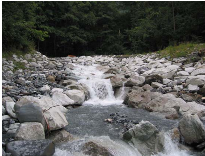
Abb. 11: Beispiel für eine zerstörte Rampe in einem Gebirgsfluss
