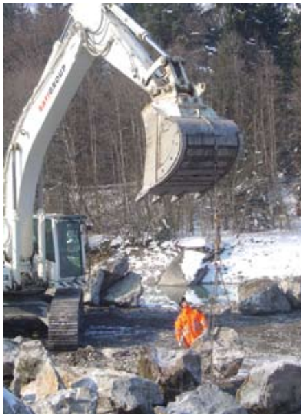
Bild 17. Bauüberwachung und Qualitätssicherung, Wiegen der Einzelblöcke.
