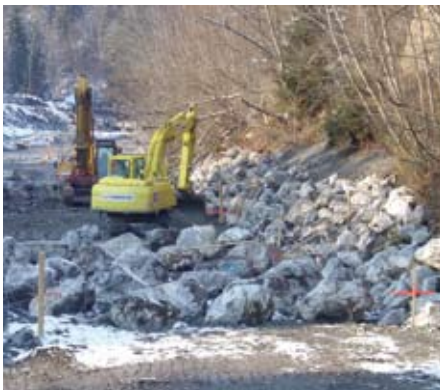
Bild 13. Erstellen Uferschutz im Vorlauf zum Versetzen der Einzelblöcke der Blockrampe.
