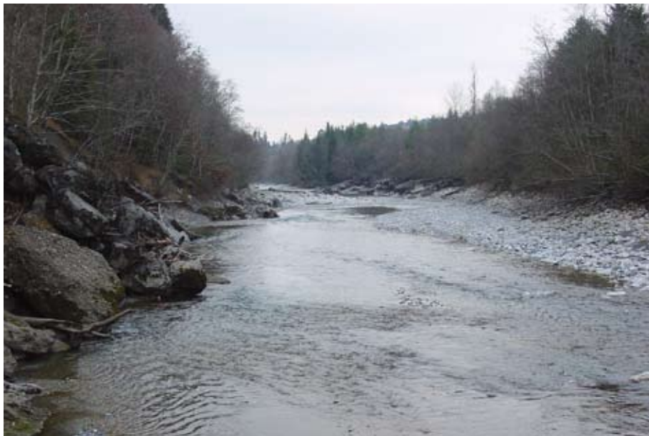
Bild 1. Kander vor Baubeginn 2004; begradigter, durch viele Bühnen eingengerter Flusslauf mit Breiten um die 32 m; Sohle eingetieft, Auendynamik weitgehend verschwunden.
