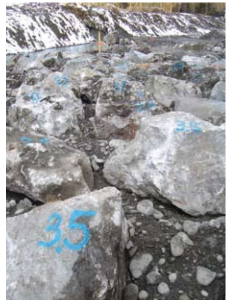
Bild 18. Bauüberwachung und Qualitätssicherung, angeschriebene Massen auf Einzelblöcken.
