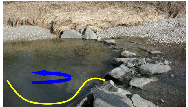
Kolkbildung hinter überströmbarer Schwelle Wigger, Gemeinden Langnau und Reiden vif Januar 2002
