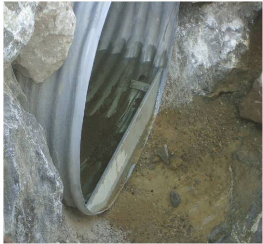
Bild 2 Schwelle am Rohrende
