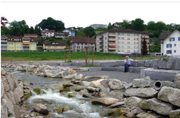
Natursteinelemente sorgen für eine vielfältige Sohlenstruktur Gemeinde Büron, vif Mai 2008
