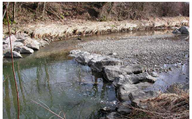
Niederwasserrinnen und Kolke bereichern die Sohlenstruktur Wigger, Gemeinden Reiden und Langnau vif Januar 2002
