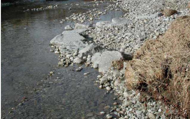
Überströmbare Steinbühne ergibt Sohlenstruktur Wigger, Gemeinden Reiden und Langnau vif Januar 2002
