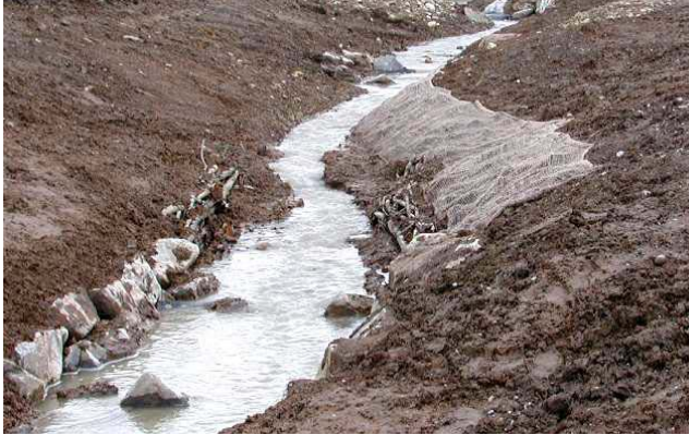
Böschungsschutz mit Jutegewebe Mürgibach, Gemeinde Neudorf
