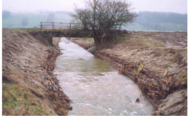
Böschungsschutz mit toten Faschinenwalzen Wina, Gemeinden Beromünster & Gunzwil
