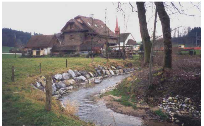
Mehrlagiger Blocksatz in Aussenkurve Grosse Aa / Sellenbodenbach, Gem. Neuenkirch
