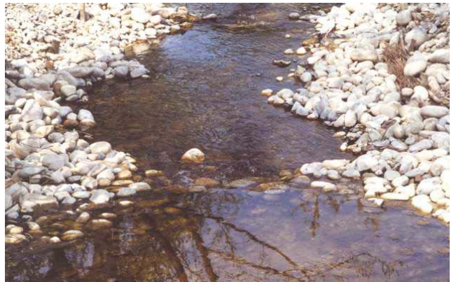
Rundkiesschüttungen als Erosionsschutz Grosse Aa / Sellenbodenbach, Gem. Neuenkirch
