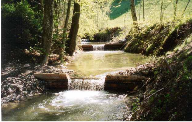
Holzquerschwelle mit Niederwasserrinne Buchwigger, Gem. Hergiswil und Willisau Land vif Mai 2002
