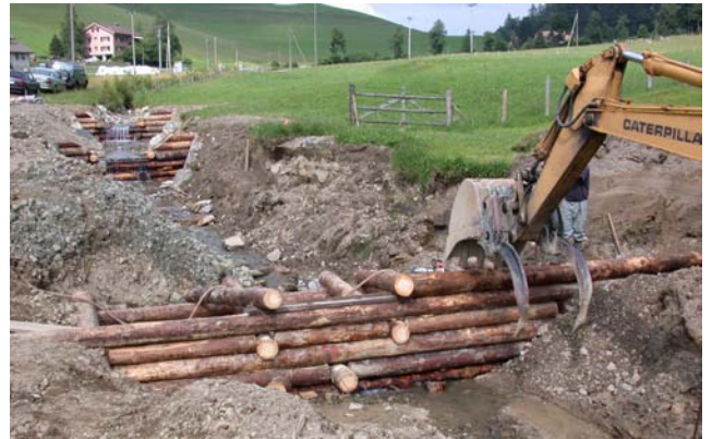
Bau einer Holzkastensperre Chrümelbach, Gemeinde Schwarzenberg vif Juli 2002
