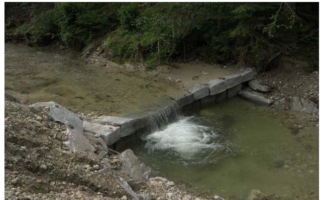
Blockschwelle mit Niederwasserrinne Enziwigger, Gemeinde Hergiswil vif Juli 2011
