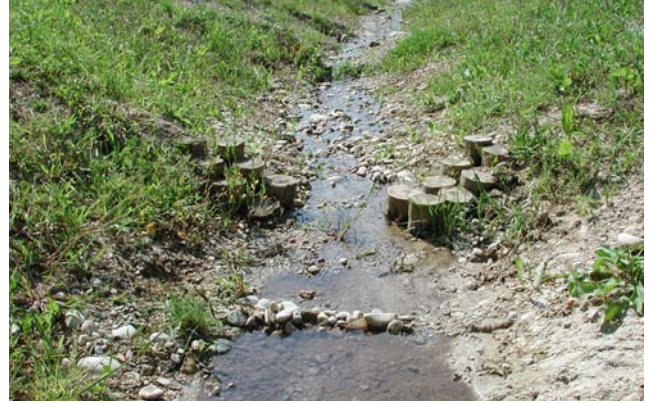
Zweireihige Palisadenschwelle Mühligrundbach, Gemeinde Willisau-Stadt vif August 2002
