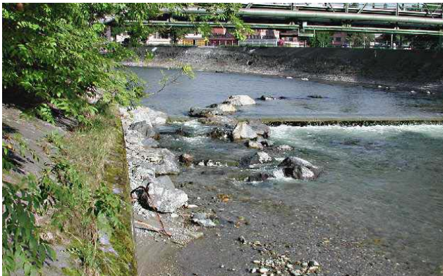
Im Flusslauf seitlich angelegter Fischaufstieg mit Beckenstruktur Kleine Emme, Gemeinde Emmen vif Mai 2002
