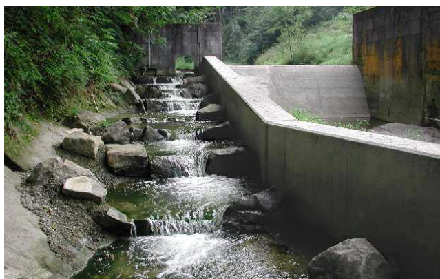
Fischaufstieg im Fassungsbereich eines Entlastungskanal Würzenbach, Stadt Luzern vif August 2001
