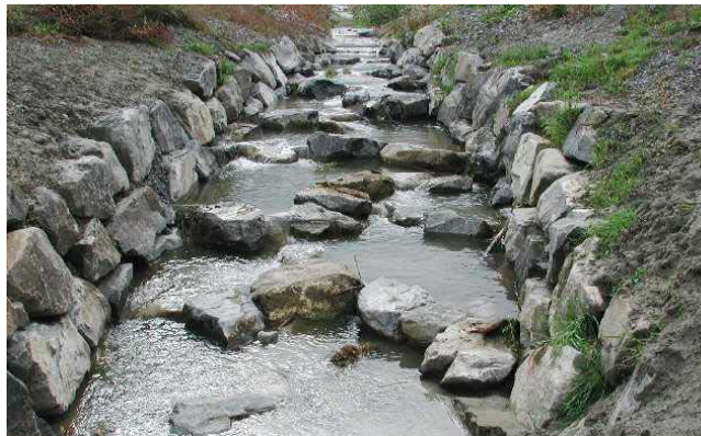
Fischaufstieg ausgestaltet als Rauhgerinne mit Beckenstruktur Bäumlibach, Gemeinde Root vif September 2002
