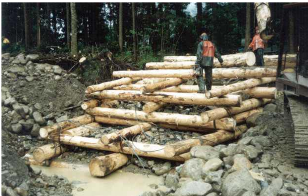
Überströmbare, grosse Holzbühne während dem Bau Rotbach, Gemeinde Flühli vif Juni 1997
