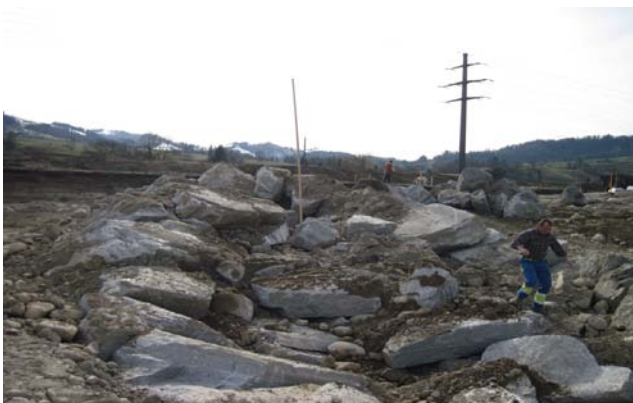
Überströmbare grosse Steinbühne während dem Bau Kleine Emme, Gemeinde Malters vif April 2010
