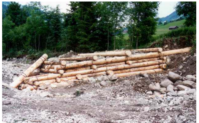
Überströmbare, grosse Holzbühne während dem Bau Rotbach, Gemeinde Flühli vif Juni 1997
