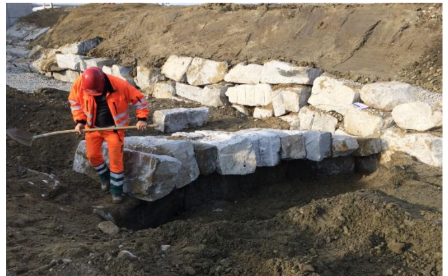
Überhängende Steinschwelle (Bauzustand) Rotbach, Gemeinde Emmen ewp AG Luzern Dezember 2016
