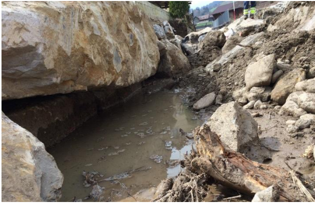
Fischgaragen (Bauzustand) Manebach, Gemeinde Schüptheim
