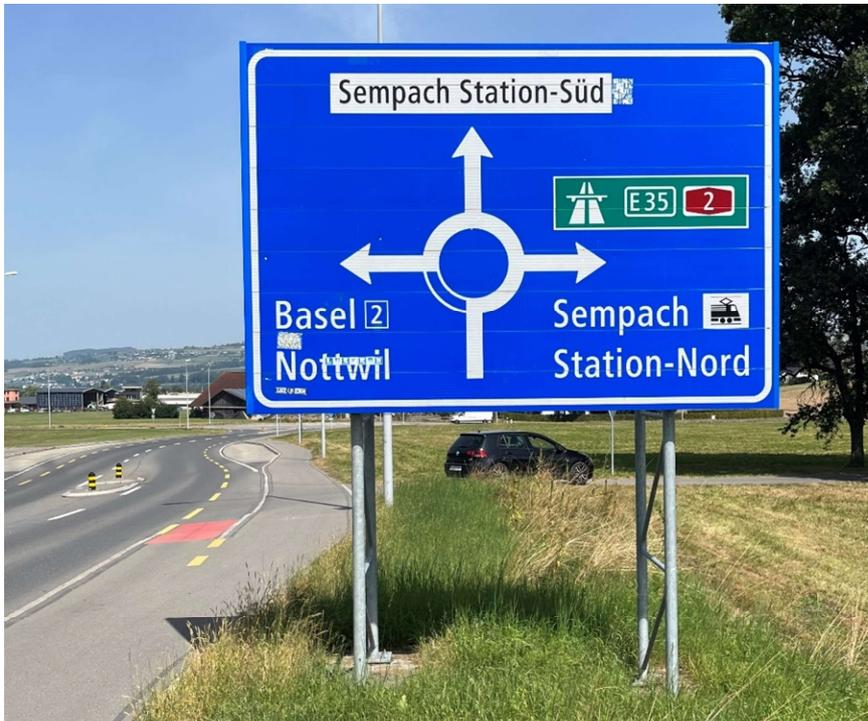
Abbildung 18 Foto eines Vorwegweisers bei Kreisverkehrsplatz ausserorts
