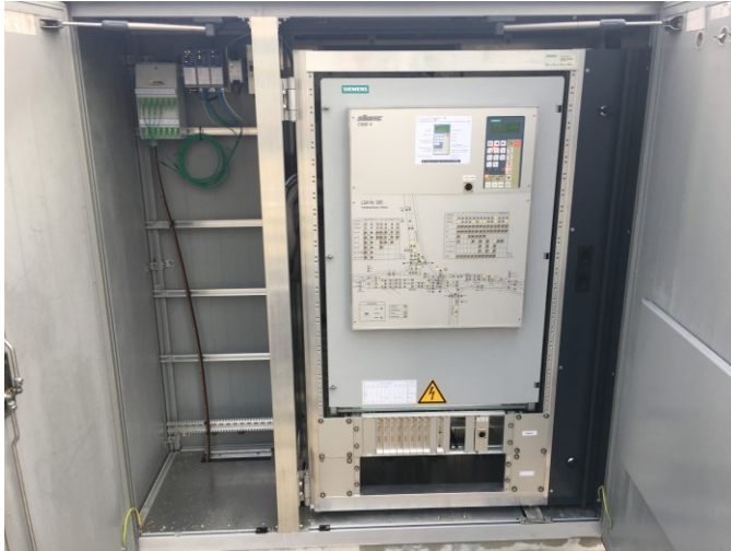
Abbildung 4: Einbau mit separatem Fernwirk-Teil
