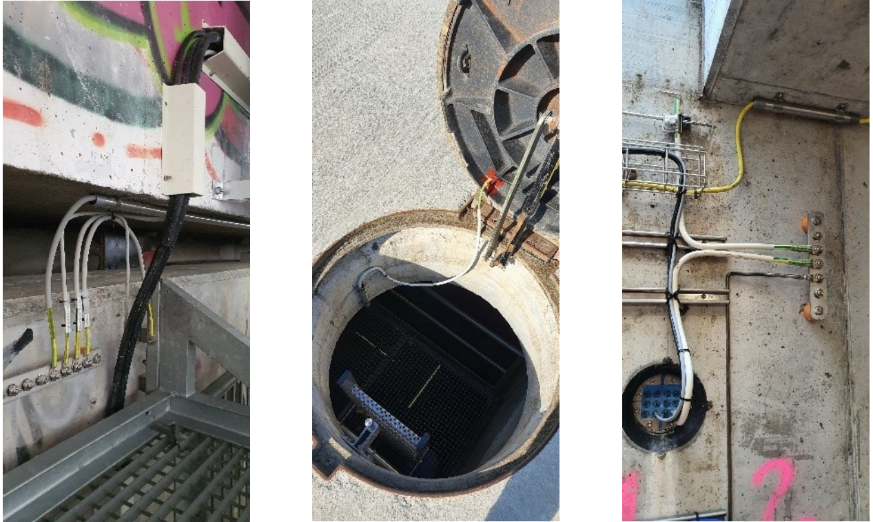
Abbildung 4: Beispiel Erdungsanschlüsse
