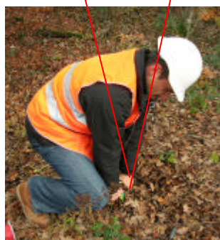
Sonde und Hilfserder werden im neutralen Erdreich gesetzt.
