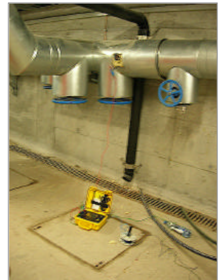
Erdungsmessung an der Wasserleitung
