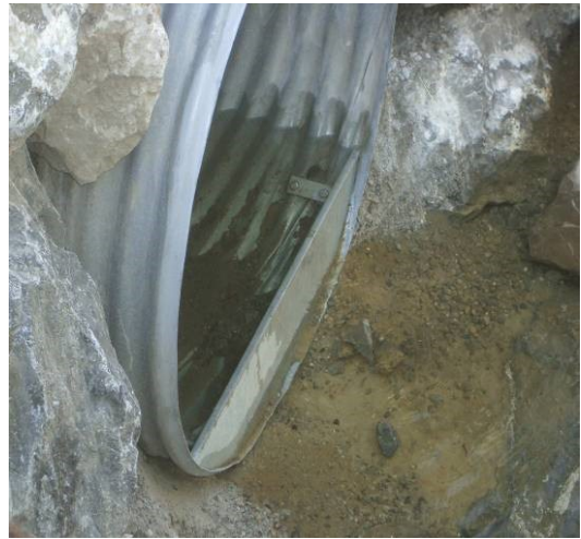
Bild 2 Schwelle am Rohrende
