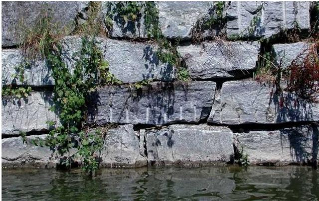
Detailaufnahme einer unvermörteltes Blocksatzmauer,
