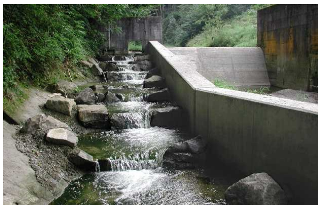
Fischaufstieg im Fassungsereich eines Entlastungskanal Würzenbach, Stadt Luzern vif August 2001
