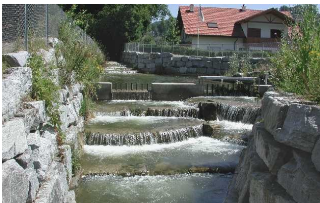
Kaskadenförmig ausgebauter Fischaufstieg Dorfbach, Gemeinde Büron vif Juni 2002
