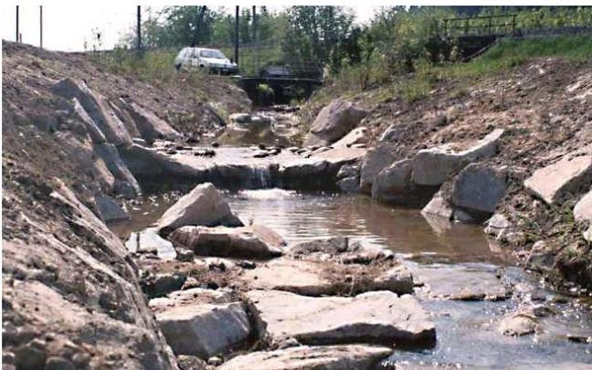
In Bachschwelle integrierte Fischunterstände bilden Rückzug-
