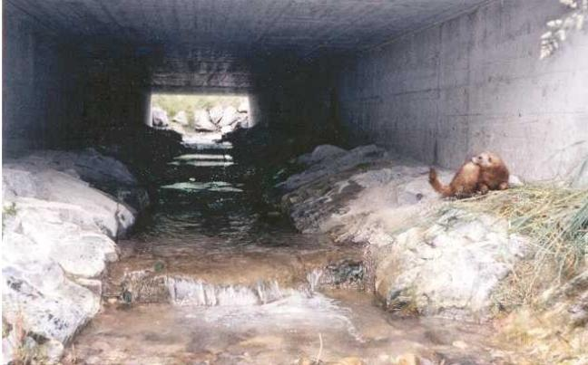
Seitliche Bermen in SBB-Durchlass für Kleintierwechsel
