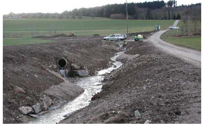
Revitalisierter Bachlauf kurz nach dem Abschluss der Arbeiten Mürgibach, Gemeinde Neudorf vif Februar 2002
