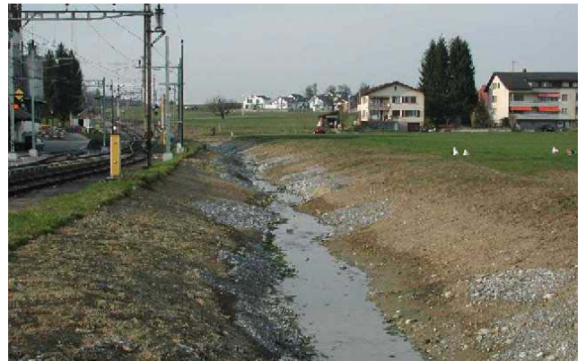
Revitalisierter Bachlauf kurz nach dem Abschluss der Arbeiten Strumpfbach, Gemeinde Eschenbach vif März 2002
