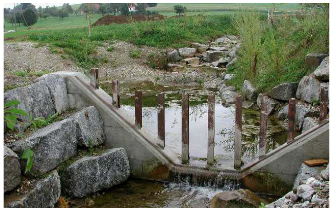
Abschlussbauwerk eines Geschiebesammlers Joggubach, Gemeinde Neudorf
