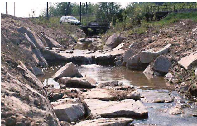
In Bachschwelle integrierte Fischunterstände bilden Rückzug- refugien in Zeiten von Niedrigabflüssen Lippenrütibach, Gemeinde Neuenkirch vif Mai 1992
