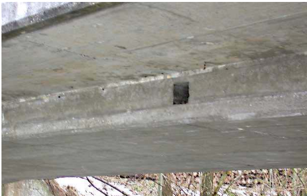
Vogelnische in Brückenplatte integriert (Baujahr 1986) Brücke Unterfeld über Wigger, Gem. Alberswil vif Februar 2003
