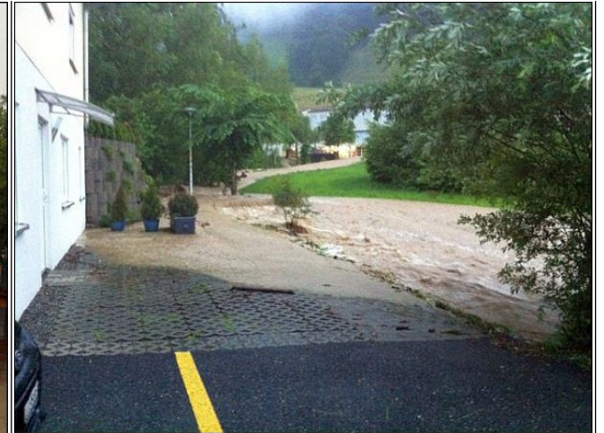
Im Bereich Dorfstrasse 3A wurde die Strasse und angrenzendes Gelände überschwemmt.
