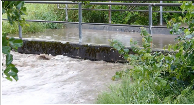
Erlibach Brücke bei der Zugstrasse (Foto StorMe.bafu)
