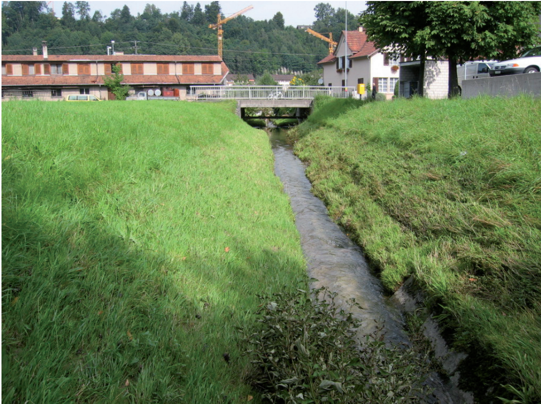
Das Gerinne des Mühlebachs in Ebikon zwischen Zentralstrasse und Riedmattstrasse mit den Spuren des Hochwassers vom 19.-22.8.2005 (Foto Scherrer AG).
