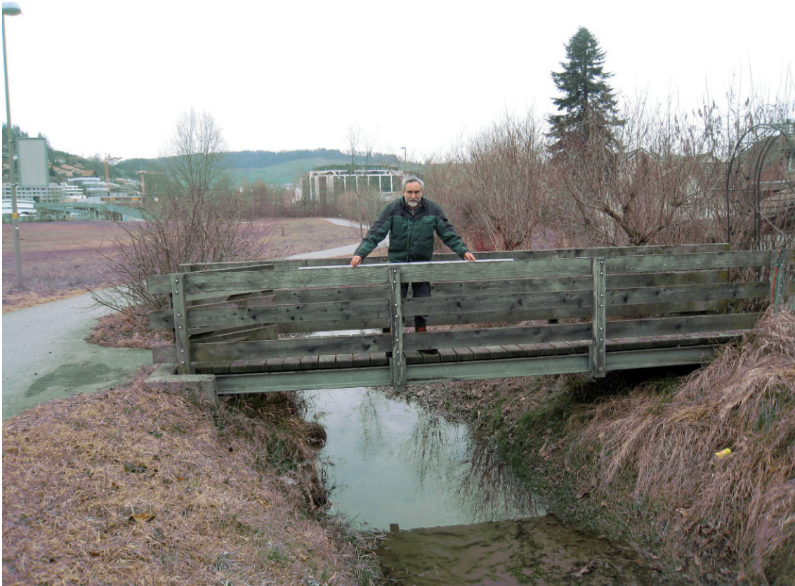
links: Kuonimatt, rechts: teilweise von Überflutung betroffene Siedlung Riedstrasse.
