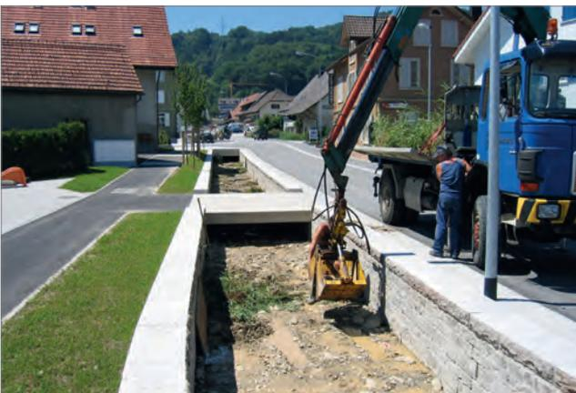
→ 10-86 2003. Kanalisierter Bachlauf im Ausgangszustand, der den Hochwasserabfluss nicht gewährleisten konnte.
