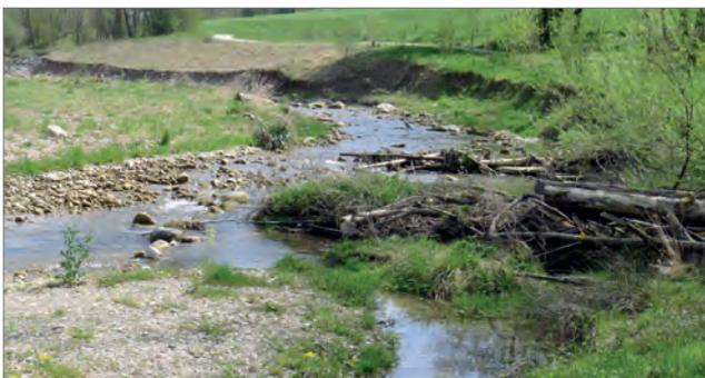
**6-5 Zielzustand** Revitalisiertes und hochwassersicher ausgebautes Gewässer, Steilwand, Kiessohle mit unterschiedlichem Substrat, strukturierende und lenkende Einbauten mit Blöcken, Niederwassergerinne punktuell beeinflusst durch Strukturierungselemente. Der Zielzustand liegt nahe beim Referenzzustand, Fahrwege und Werkleitungen behindern eine vollständig freie Entwicklung. Revitalisierte Reppisch bei Landikon, ZH.
