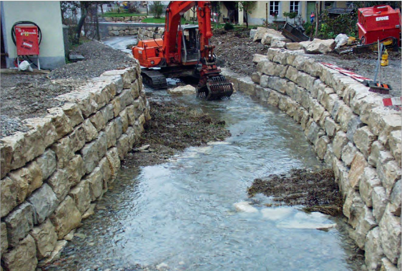
↑ 10-48 November 2001. Bau des Gewässers. Strukturierung der Sohle mit Blöcken und Hochstaudensoden. Bei erhöhter Wasserführung kurz nach dem Einbau besteht das Risiko, dass die Soden abgeschwemmt werden.
