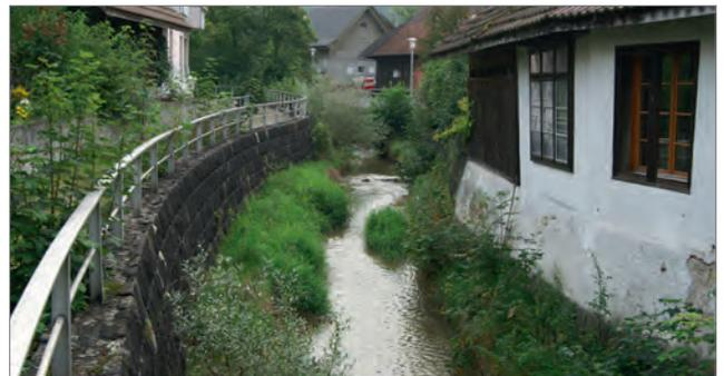
**6-11 Zielzustand** Hochwasserentlastungskanal unter dem Bachlauf, begrenzte Wassermenge im offenen Lauf. Mit Querhölzern stabilisierte Kiessohle auf Betondeckel. Zielzustand liegt aufgrund der räumlichen Restriktionen weit entfernt von Referenzzustand. Zusätzliche Massnahmen für die Gestaltung des Niederwassergerinnes in Form von Initialpflanzung eines Hochstaudensaumes und Sohlenmodellierung sind notwendig. Dorfbach Spreitenbach, AG.
