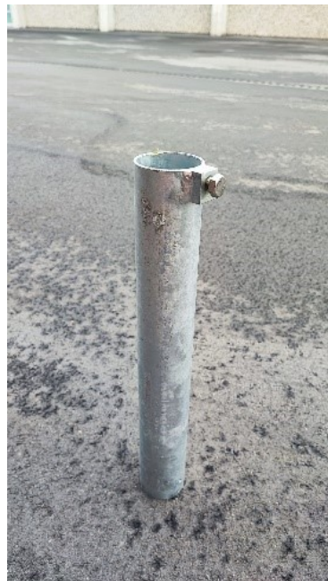
Bodenhülse nachträglich mit Kernbohrung bündig versetzt
