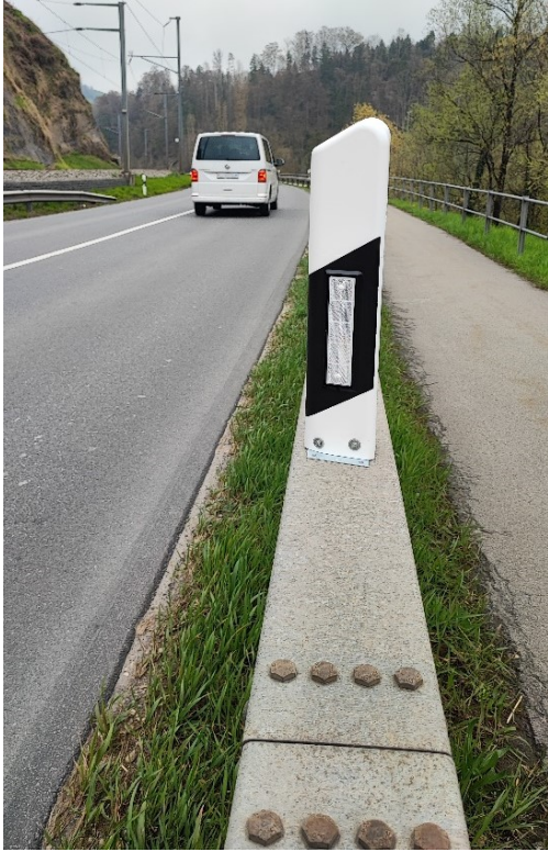
Der Leitpfosten kurz auf das Kastenprofil geschraubt.
