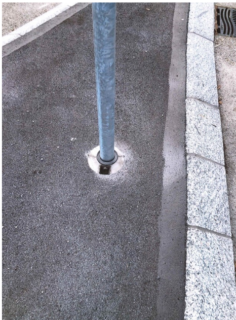
Bodenhülse nachträglich mit Kernbohrung bündig versetzt
