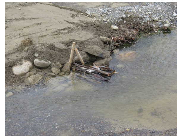
Faschinen als Strukturierungselemente
