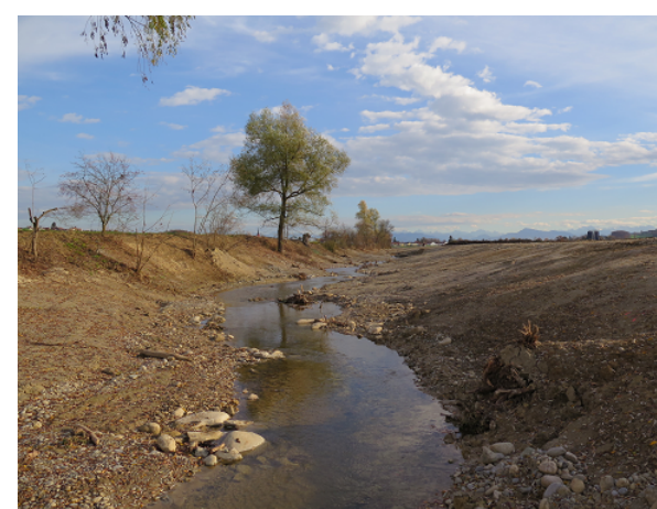
Entwicklung des Gerinnes durch Normalabfluss
