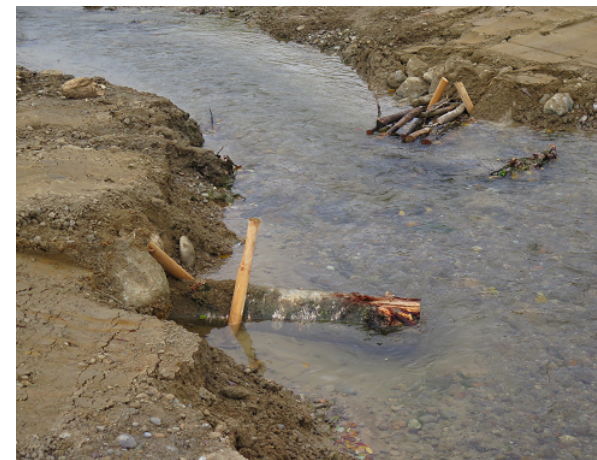
Buhnen aus Baumstämmen und Faschinen
