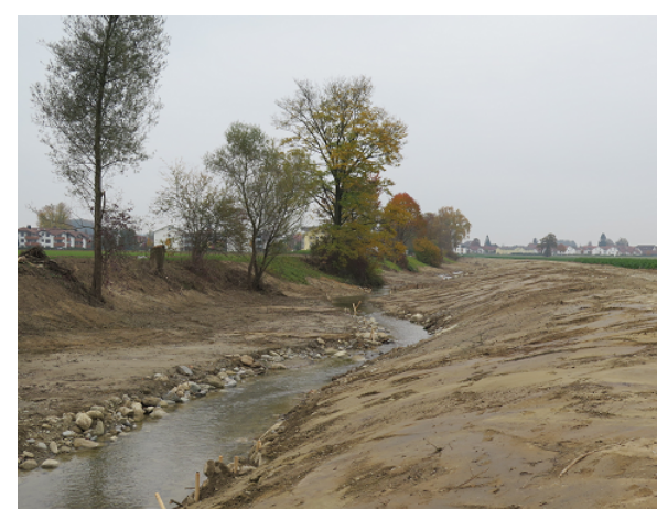
Punktuelle Initiierung eines Niederwassergerinnes
