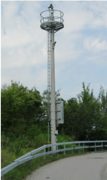
Masten für Kameras, Sensoren, Antennen usw. müssen mit dem lokalen Potenzialausgleich und mit dem Mastfundament sichtbar verbunden werden.
