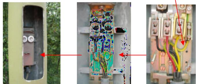
Je nach Elementtyp erfolgt die Verbindung über die leitende Rückwand des Sicherungselementes, oder über eine separate Verbindung.
