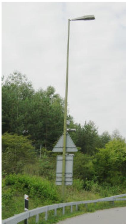
Der metallene Kandelaber wird mit dem Schutzleiter des Zuleitungskabels verbunden. Der minimale Querschnitt des Schutzleiters beträgt  $16 \text{ mm}^2$ . Dies gilt auch für Kandelaber, die aus Tunnelzentralen gespeist werden.
