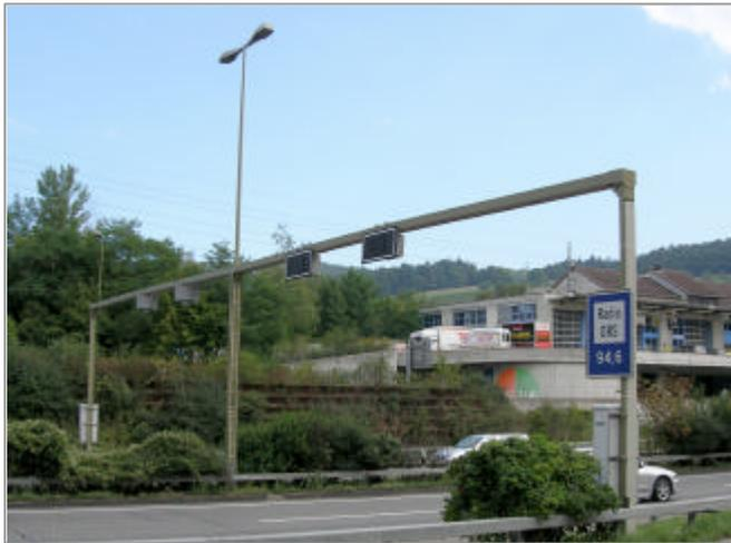
Für Signalbrücken werden keine separaten Erder erstellt. Ein separates isoliertes Cu-Seil von 50 mm<sup>2</sup> wird als Potenzialausgleichsleiter mitgeführt.
