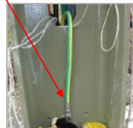
Signalbrücken müssen mit dem Potenzialausgleich durch ein Cu-Seil von mind. 50 mm<sup>2</sup> sichtbar verbunden werden.
