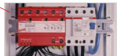
Die Ausfallsignalisierung der Überspannungsschutzelemente ist auf das Übergeordnete Leitsystem (ÜLS) des TBA Kt. Zürich aufzuschalten. Siehe auch Teil 2 Kapitel 2.1.2.6 „Überwachung der Blitzstrom- und Überspannungsschutzelemente“.
