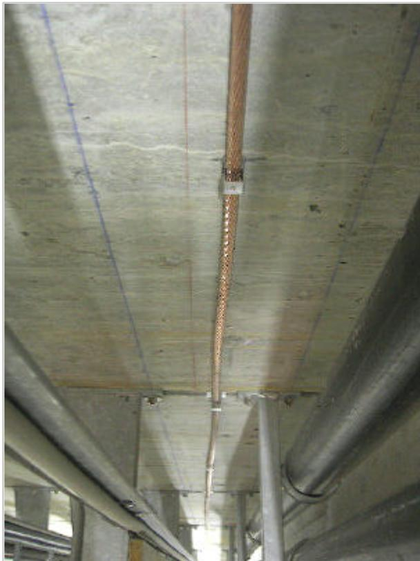
Für jede einzelne Fahrbahn wird ein separater Potenzialausgleichs-Leiter geführt. Diese parallel laufenden Leiter werden jeweils bei den Querverbindungen und im Bereich der Zentralen miteinander verbunden.
