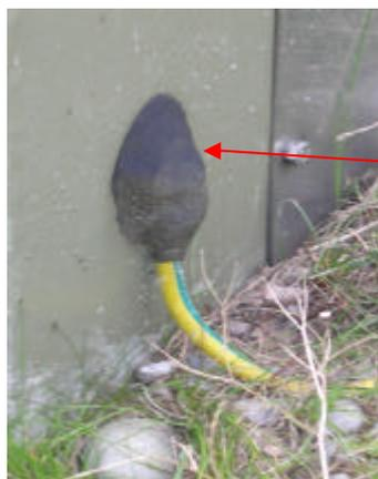
Wenn als Schutz gegen Korrosion durch Streusalz keine Blechabdeckung angebracht werden kann, ist der Anschluss mit plastischer Dichtungsmasse abzudecken, die alterungsresistent gegen Aushärten und Rissbildung sein muss.
