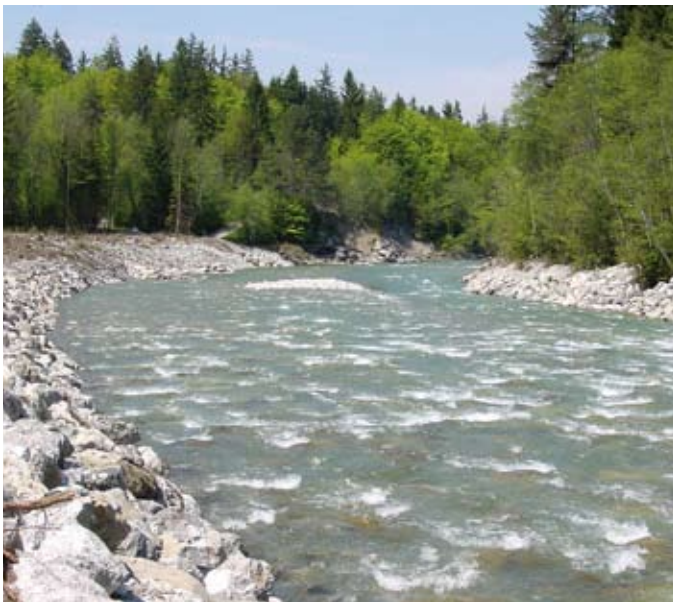
Bild 21. Blick flussaufwärts auf die fertige Blockrampe.
