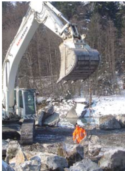
Bild 17. Bauüberwachung und Qualitätssicherung, Wiegen der Einzelblöcke.
