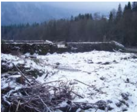
Bild 12. Durch Abholzen freigelegte Buhne.
