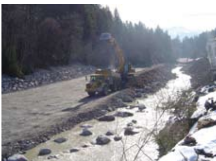
Bild 14. Überschütten der Blöcke, Abschluss erste Phase beim Bau der Blockrampe.
