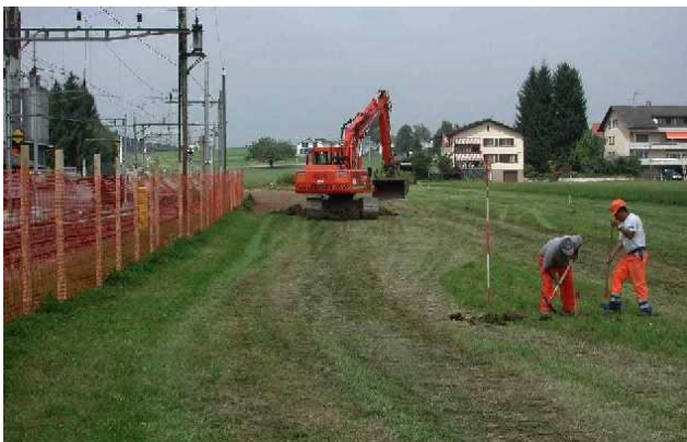
In Röhren verlegter Strumpfbach, Aufnahme vor dem Ausbau Strumpfbach, Gemeinde Eschenbach vif August 2001
