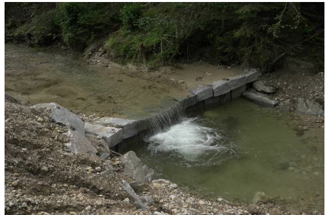
Blockschwelle mit Niederwasserrinne Enziwigger, Gemeinde Hergiswil vif Juli 2011
