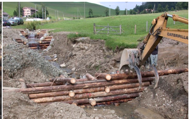
Bau einer Holzkastensperre Chrümelbach, Gemeinde Schwarzenberg vif Juli 2002
