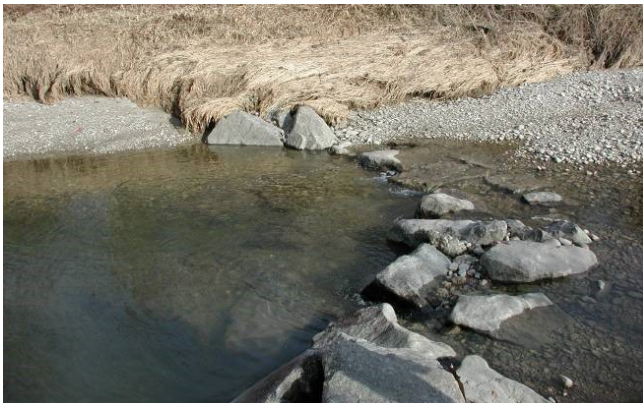
Gebogene Blockschwelle mit Niederwasserrinne Wigger, Gemeinde Reiden, Ortsteil Langnau vif Januar 2002
