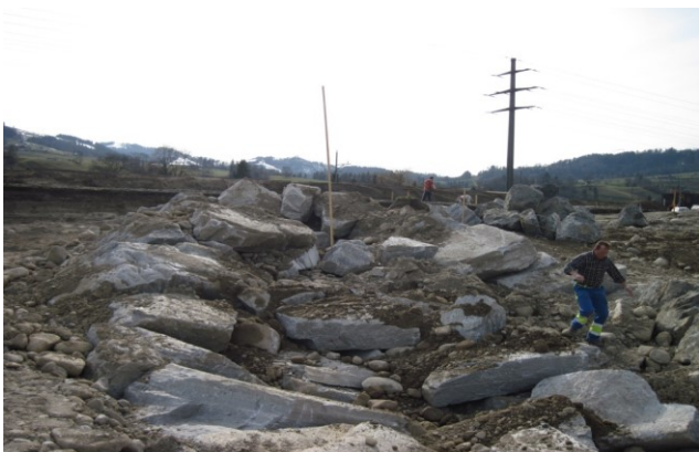
Überströmbare grosse Steinbühne während dem Bau Kleine Emme, Gemeinde Malters vif April 2010
