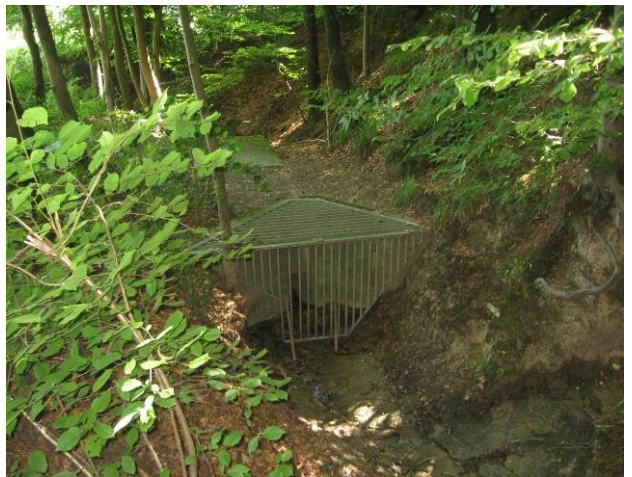
Einlauf mit Schwemmmaterialrückhalt
