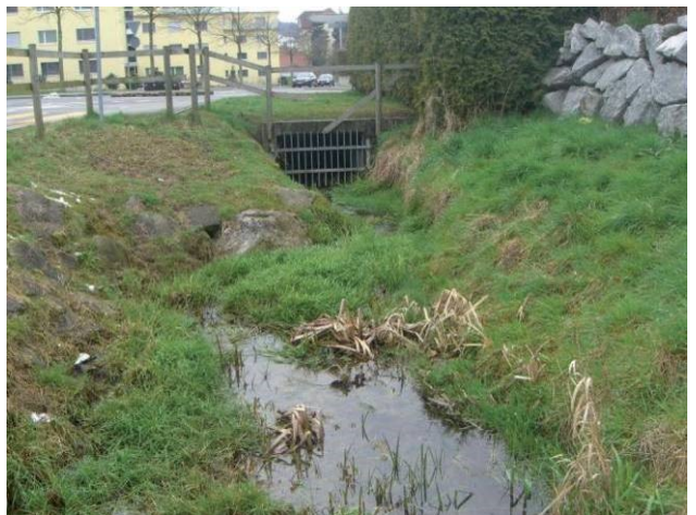
Absetzbecken oberhalb eines Durchlasses
