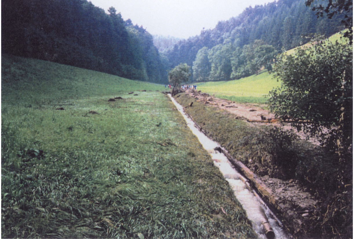
Abb. 4.2: Spuren des Hochwassers vom 16.6.1988 wenige Meter oberhalb des Einlaufes des Ruessgrabens beim Hof Oberstalden
