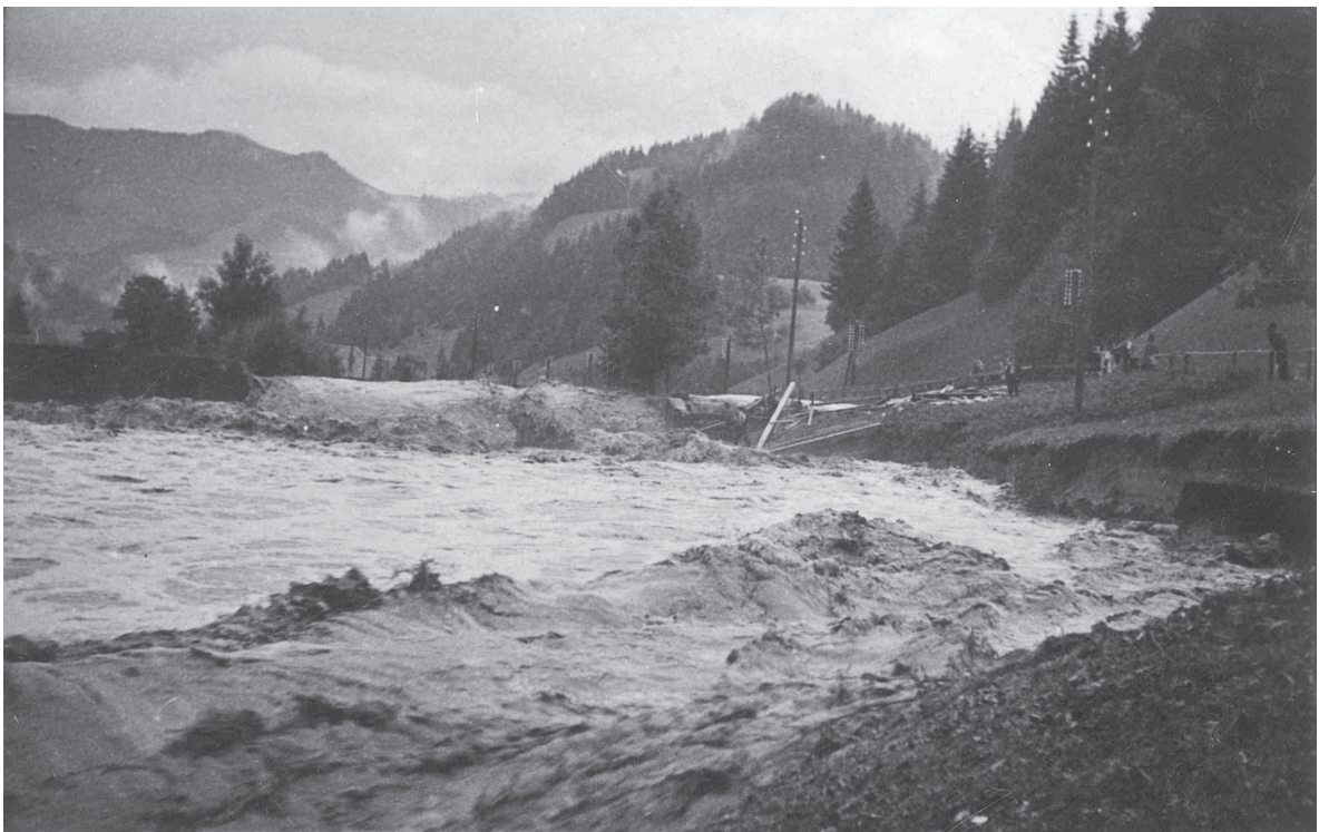
Die Hochwasser führende Ifis bei Kröschenbrunnen am 4.9.1936, Foto: Tiefbauamt Kt. Bern, Oberingenieurkreis IV
