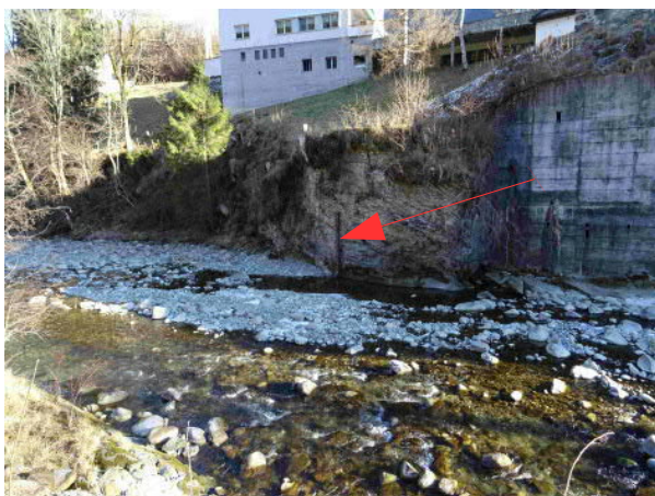
Abb. 3.3: Pegel Waldemme – Flühli am 22.12.2016 in Fliessrichtung (roter Pfeil).
