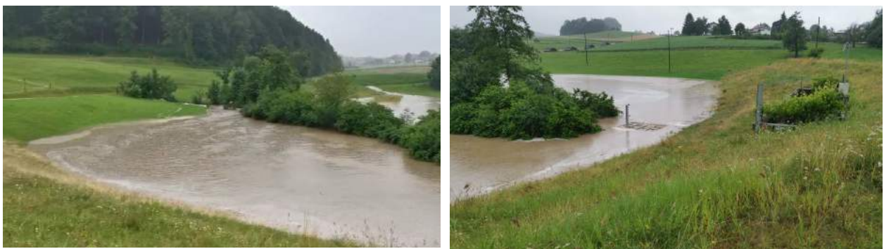
Abb. 4.3: Füllung des HRB Pfaffnern - Schiessstand Pfaffnau beim Ereignis vom 7.8.2021.
