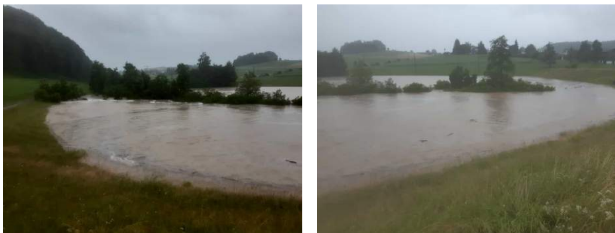
Abb. 4.1: Füllung des HRB Pfaffnern - Schiessstand Pfaffnau beim Ereignis vom 24.6.2021.
