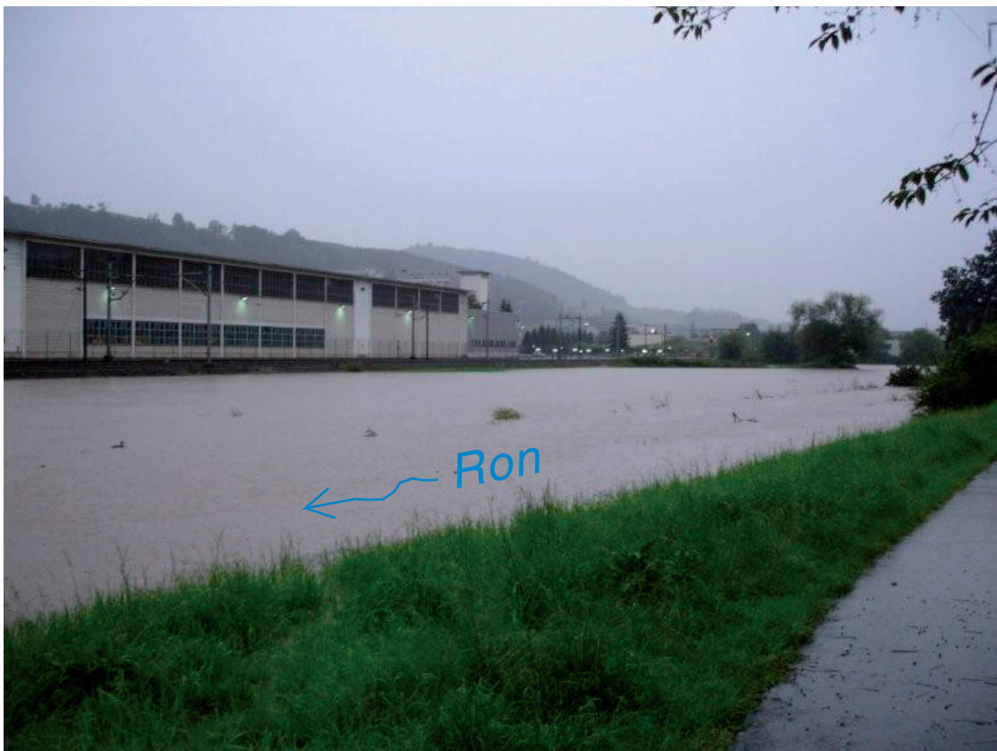
Die Hochwasser führende Ron mit überflutetem Landwirtschaftsland bei Ebikon am 8.8.2007, Foto: vif
