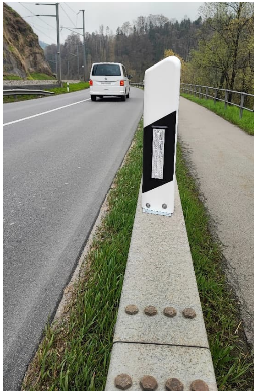
Die Leitpfosten kurz auf das Kastenprofil geschraubt.
