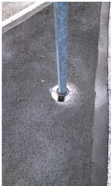
Bodenhülse nachträglich mit Kernbohrung bündig versetzt
