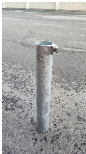
Bodenhülse nachträglich mit Kernbohrung bündig versetzt
