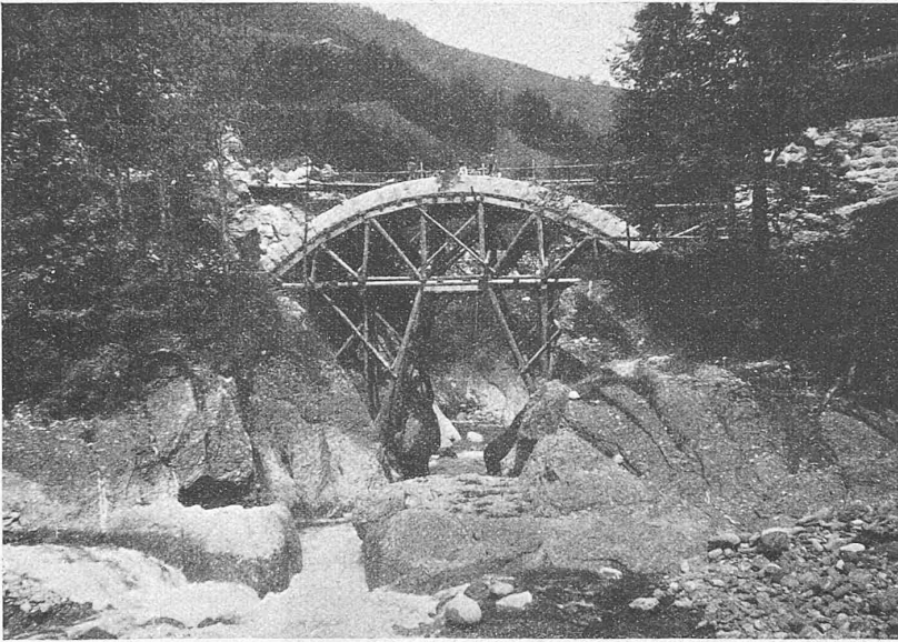
Abb. 24. Lehrgerüst der steinernen Brücke beim Kärdeli.
