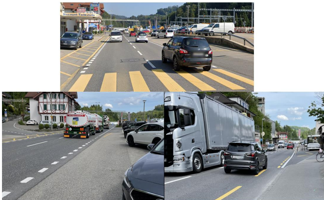
Abbildung 7: Enge Platzverhältnisse und fehlende Trottoirs
