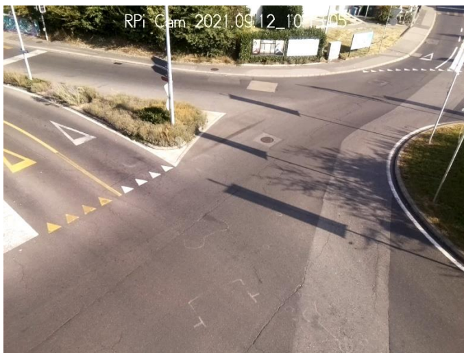
Abb. 34 Innovativer Ansatz MOB. Standort Lausanne, Av. de Provence. Quelle: AIT
