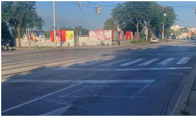
Abb. 8 Aufgeweiteter Radfahrstreifen zur verbesserten Sichtbarkeit der Velofahrenden bei einer Kreuzung. Quelle: Eigene Aufnahme (AIT)
